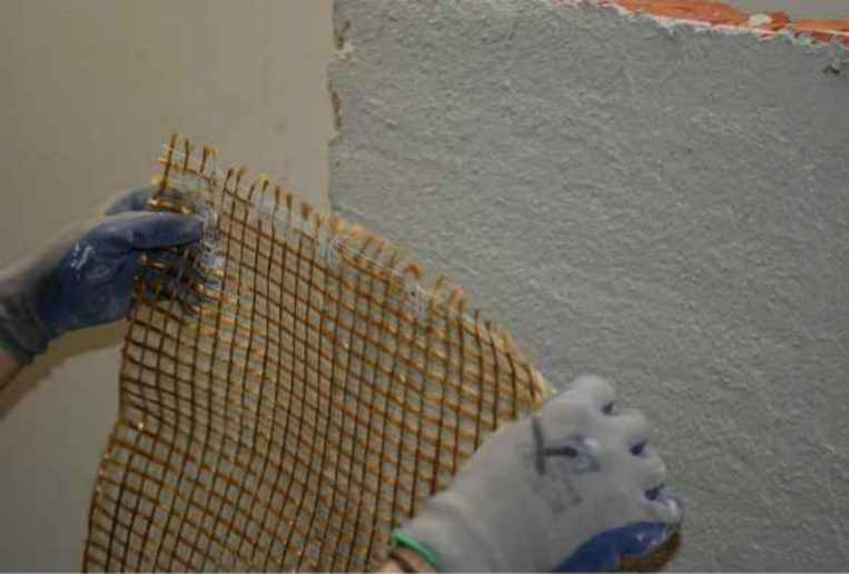
1- STESURA DELLO STRATO DI MALTA NECESSARIO
