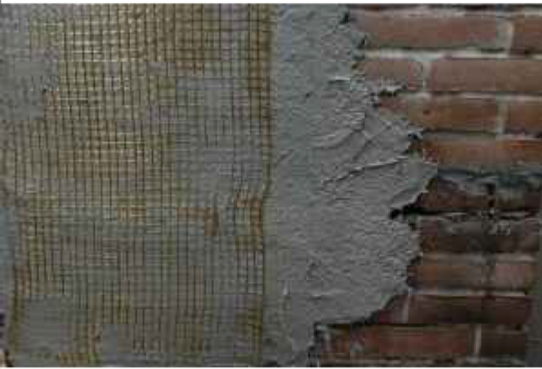
3 - ASCIUGATURA DELLA MALTA
