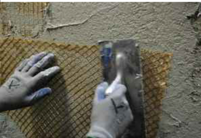
4- RIPETIZIONE DEL PROCESSO PER I FOGLI DA SOVRAPPORRE
