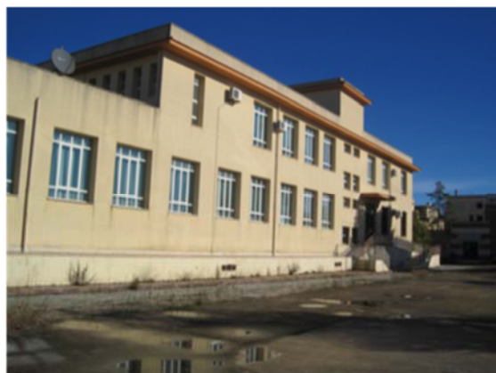
Prospetto lato sud con rampa di accesso
