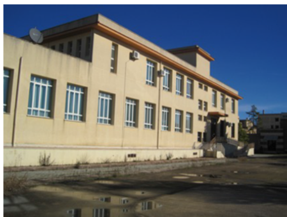
Prospetto lato sud con rampa di accesso
