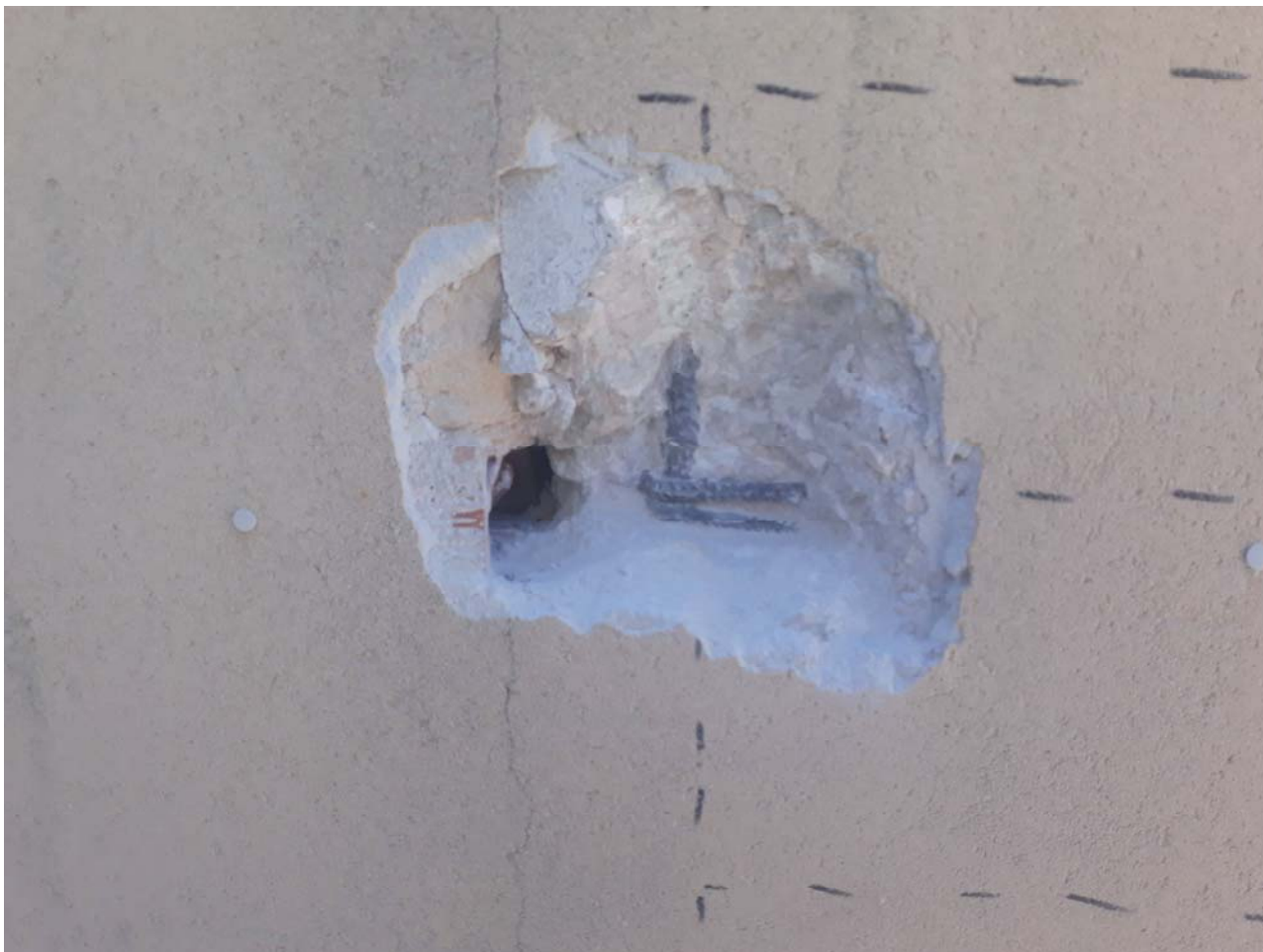
Fig. 7 – Rilievo diretto delle armature di un pilastro con particolare della piegatura a 90° delle staffe
