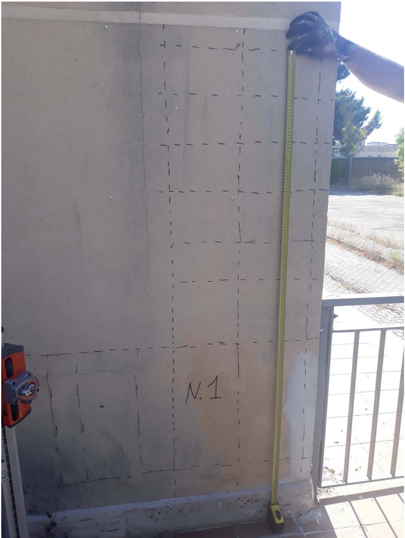
Fig. 6 – Rilievo pacometrico delle armature in un nodo trave-pilastro
