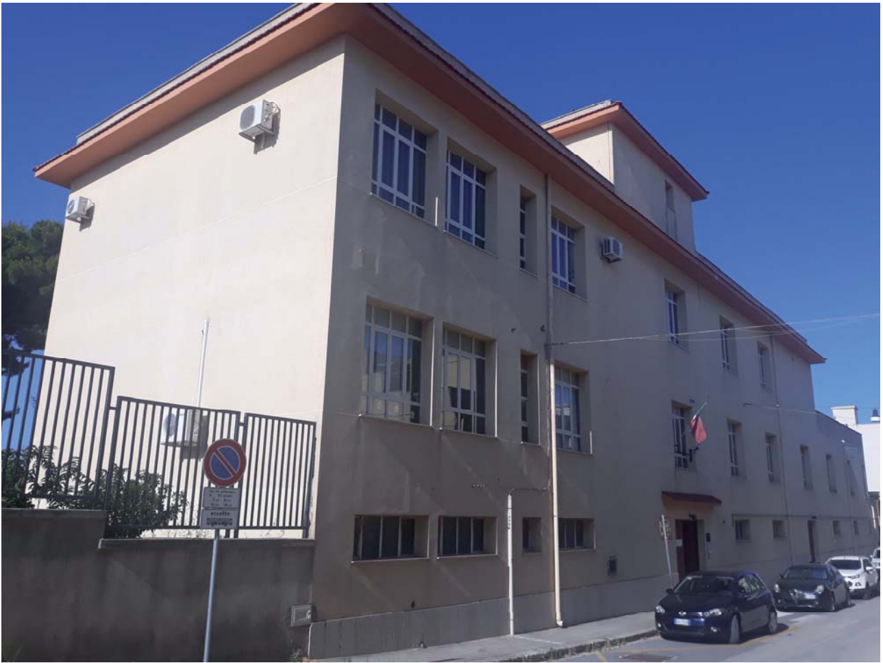
Fig. 3 – Vista facciata principale su via Messina.
