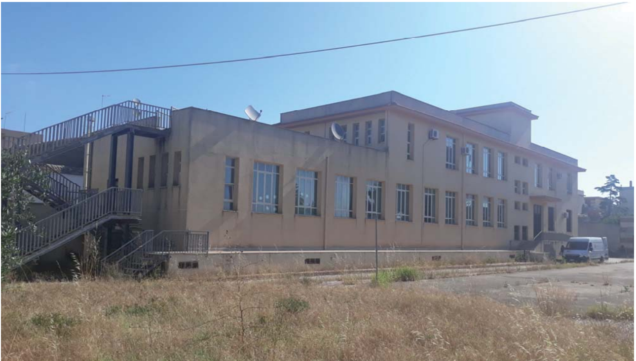
Fig. 4 – Vista facciata retrostante.
